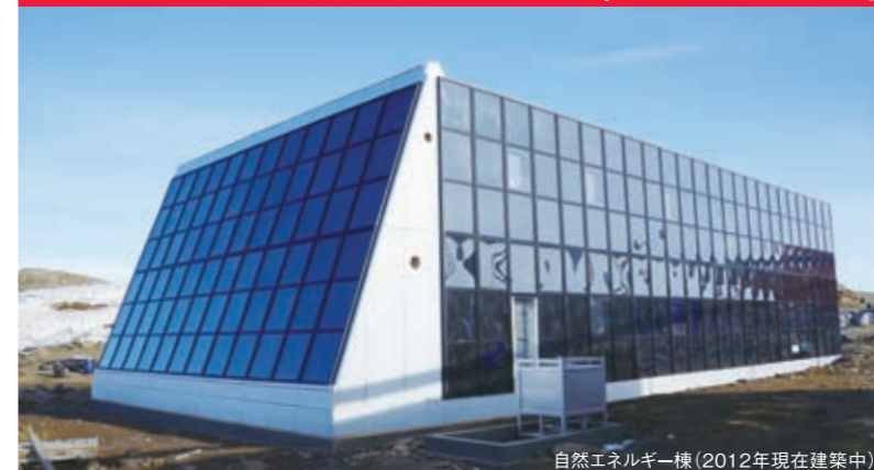
自然エネルギー棟(2012年現在建築中)
