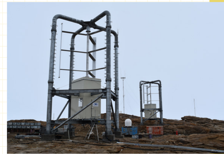
57次隊で建設した風力発電2号機。現在、3号機まで設置された。
